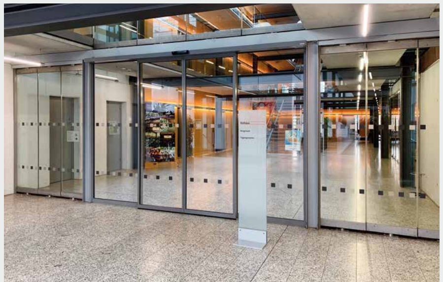
ContraSOL Glasmarkierung an Eingangselement.
