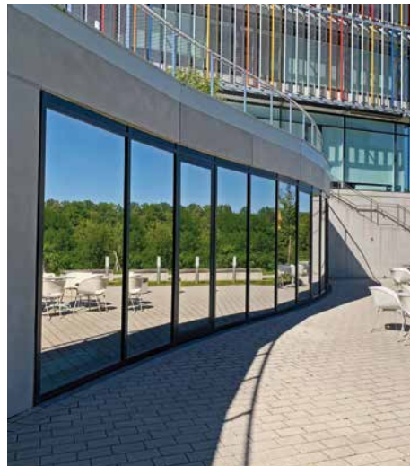
ContraSOL-Sicht- und Datenschutzfolie an Glasfassade und in „Nebeloptik“.
