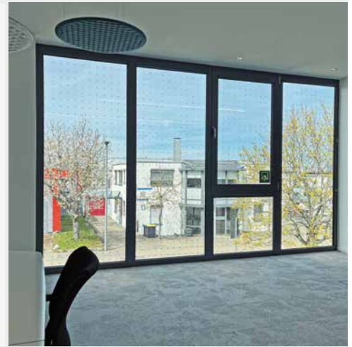
Fenster mit ContraSOL-Vogelschutzfolie.
