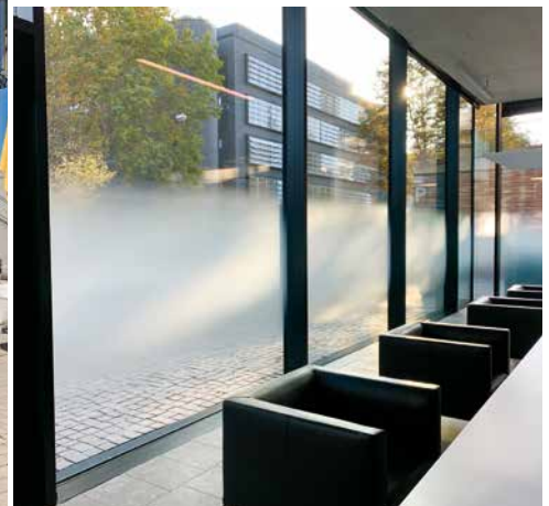
ContraSOL-Sicht- und Datenschutzfolie an Glasfassade und in „Nebeloptik“.
