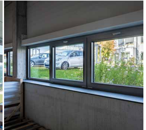
Beschichtete Fenster mit Splitterschutz- und Sicherheitsfolie – völlig glasklar.
