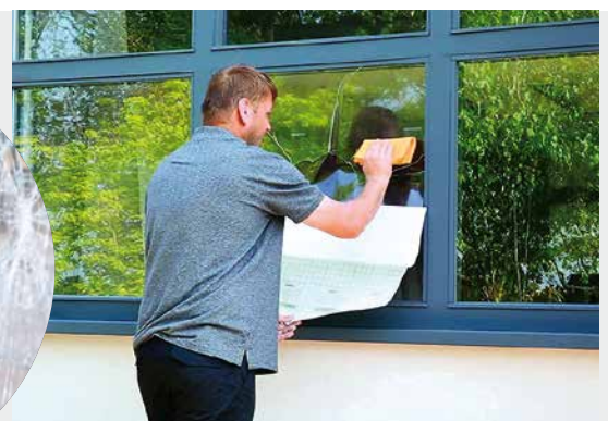
Aufkaschieren des Repairfilms auf defekte Glasscheibe.
