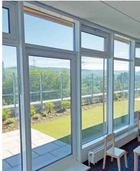
Beschichtete Fenster mit Splitterschutz- und Sicherheitsfolie – völlig glasklar.
