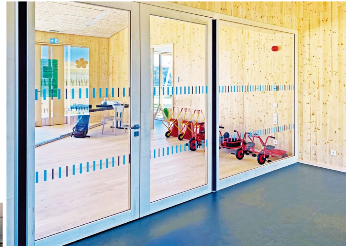
Normgerechte Glasmarkierung zweifarbig in hell und dunkel und zwei Reihen in einer Kita.
