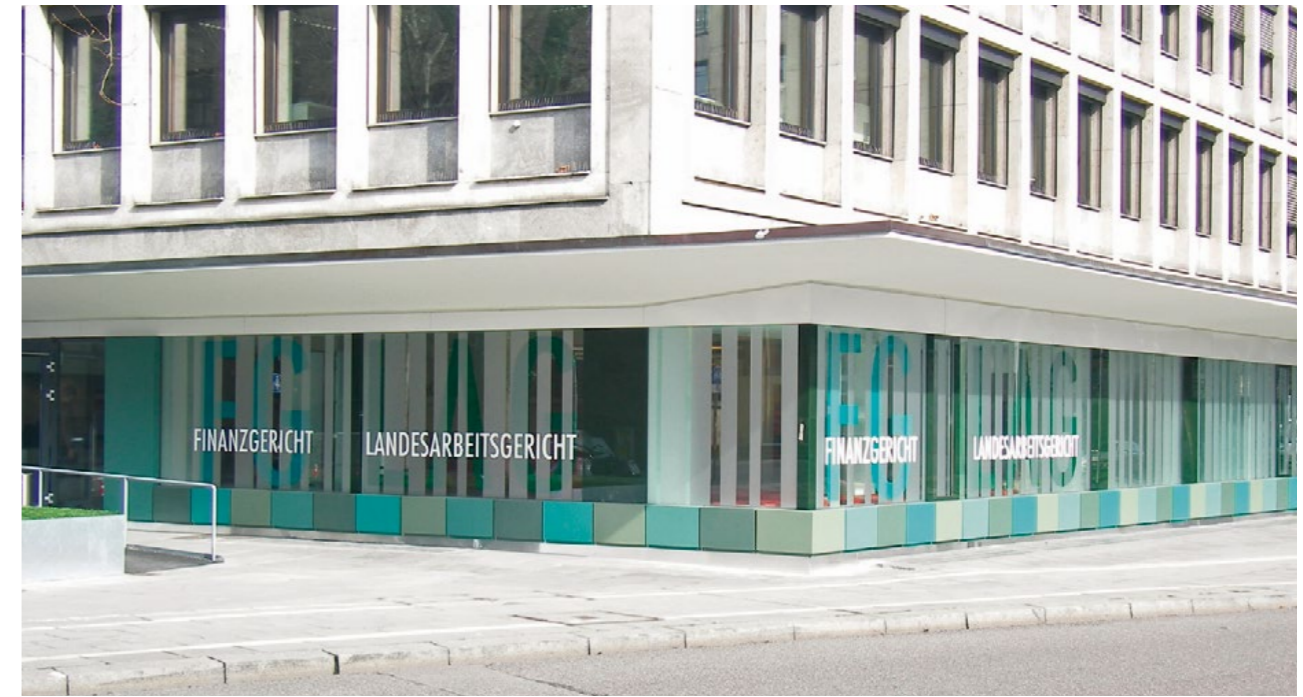
Fenster im Erdgeschoss: Sichtschutz mattiert mit Vertikalstreifen und freien Zwischenräumen. In den Gerichtsräumen werden die Sichtschutzstreifen teils versetzt angebracht, sodass kein direkter Blick ins Rauminnere möglich ist.
