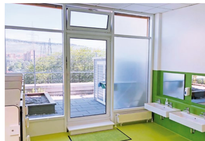
Fenster dieser Kita sind mit einer klaren Splitterschutz-Beschichtung nachträglich ausgestattet. Entsprechend den gesetzlichen Vorgaben der Unfallkasse.
