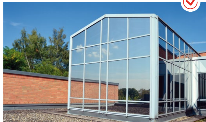
Schulungsgebäude mit ContraSOL 1.80 silber für optimalen Sichtschutz. Von innen freie Sicht nach draußen.
