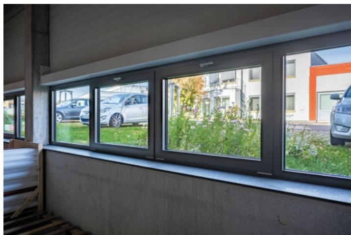
Fenster mit Sicherheitsfolie beschichtet an der Innenseite – praktisch unsichtbar.
