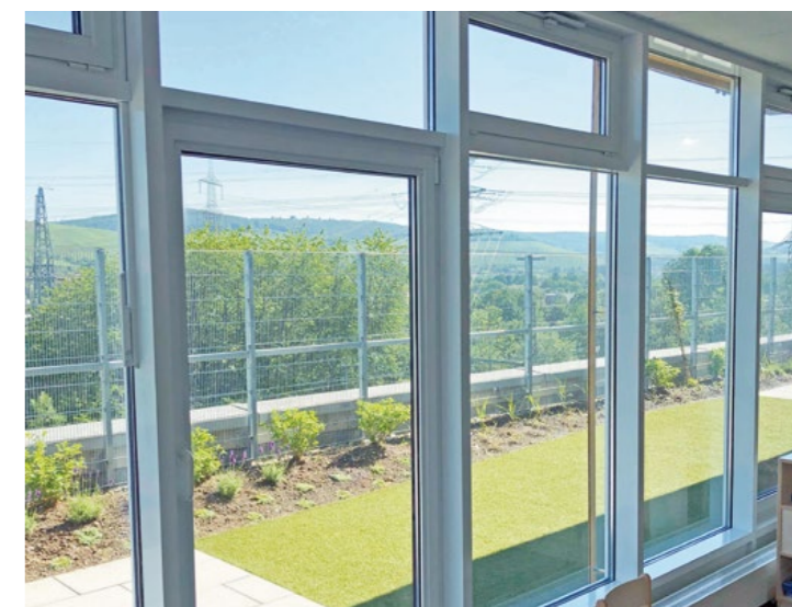
Fenster dieser Kita sind mit einer klaren Splitterschutz-Beschichtung nachträglich ausgestattet. Entsprechend den gesetzlichen Vorgaben der Unfallkasse.
