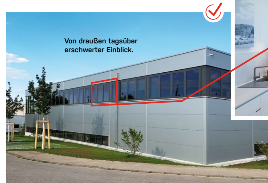
Büro- und Lagergebäude beschichtet mit ContraSOL 6.60 grau an den Fenstern im Obergeschoss. Erschwerter Einblick mit optimaler Durchsicht von drinnen. Lagerfenster im Erdgeschoß mit mattierter Sichtschutz- und Sicherheitsfolierung gegen Einbruch.
