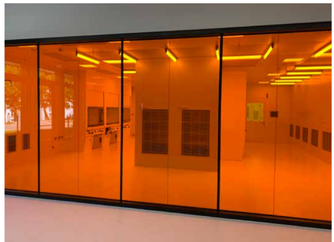
Beschichtete Glasflächen mit Lithoprotect YSA 520 in einem Reinraum.
